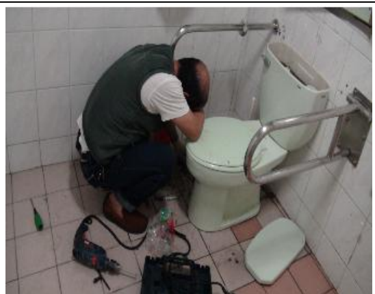
衛浴設備維修
